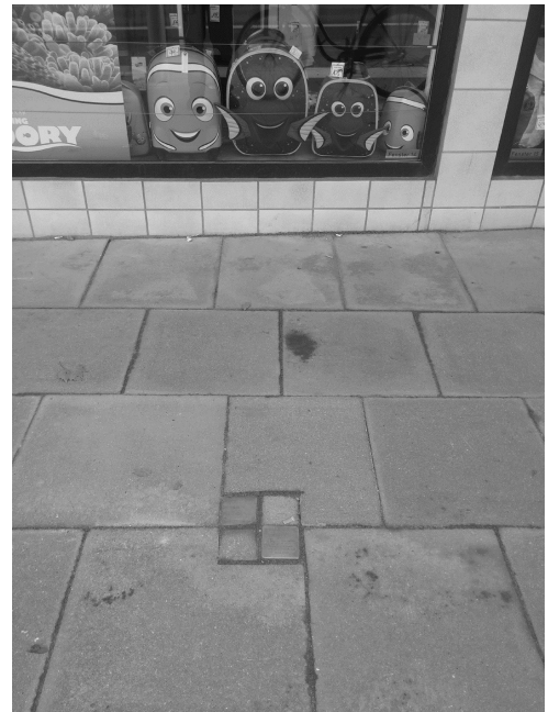
Schulweg 36, nach Umbau
